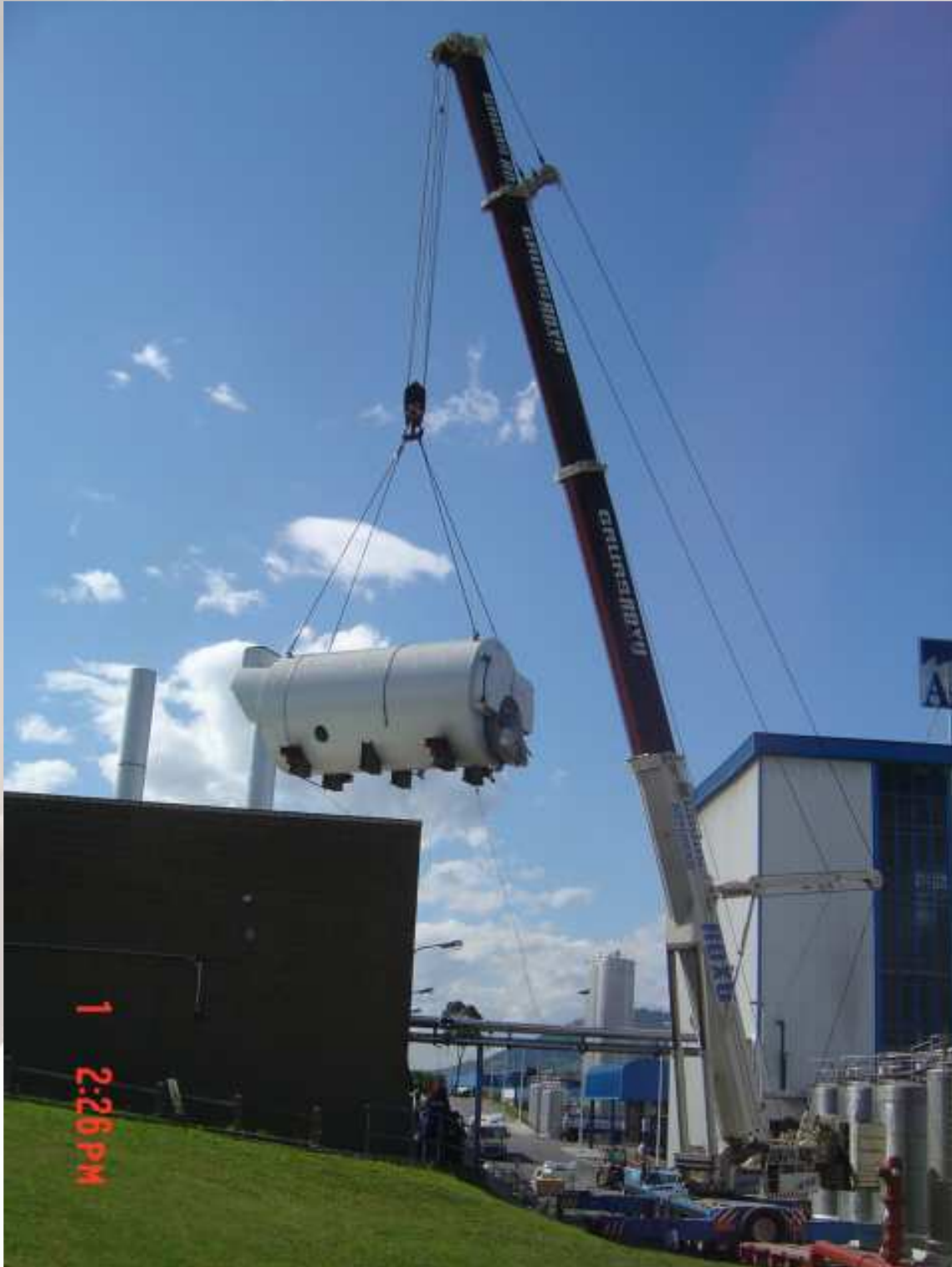
MANIOBRA DE MONTAJE DE CALDERA DE 50 Tns EN CAPSA FÁBRICA DE GRANDA
